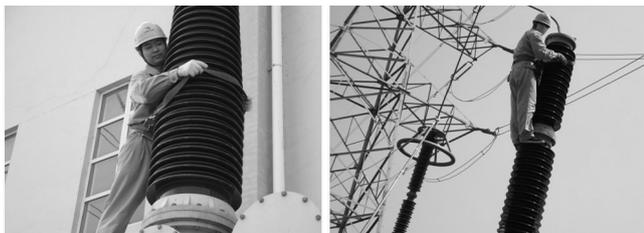
图1 人工清扫绝缘子
